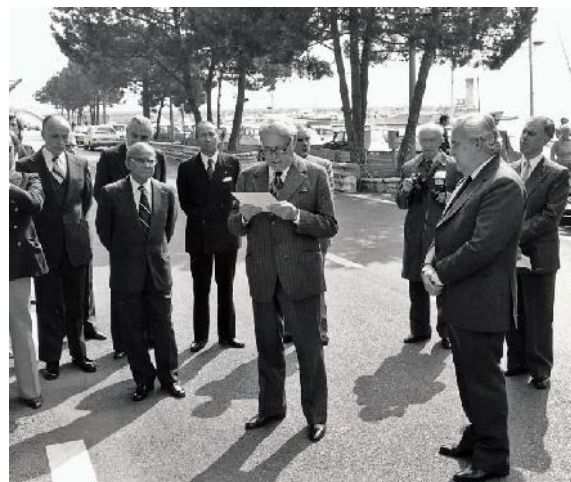
50.º aniversario de la colocación de la primera piedra del edificio de la sede del BHI
