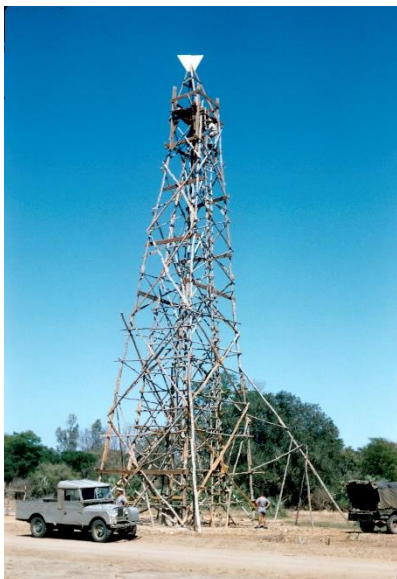
Tour géodésique de 27 m élevé par l'IGN dans l'arrière-pays de Morombé sur la côte ouest de Madagascar
