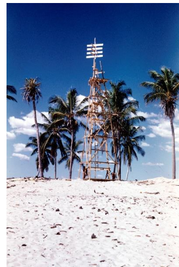
Signal de triangulation sur le haut de la plage à Madagascar
