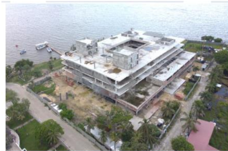
Figura 50: Estado actual de la construcción del edificio del Servicio Hidrográfico Colombiano.
