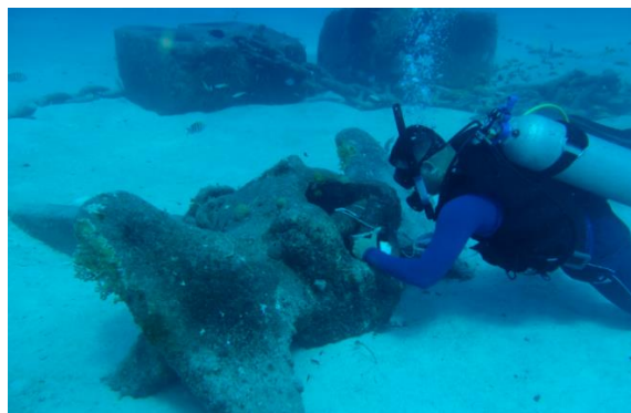
Figura 43: Instalación de mareógrafo en el Caribe Colombiano.
