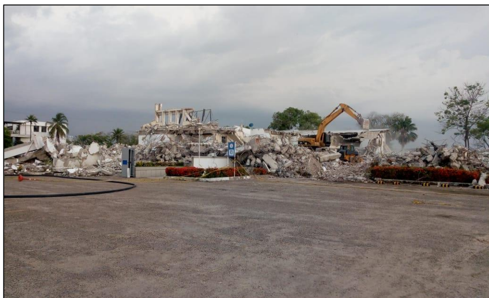
Figura 54: Demolición antiguo edificio del Servicio Hidrográfico Colombiano.
