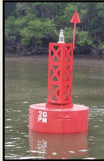
El nuevo diseño tiene varios beneficios uno de ellos es el costo de construcción que genera un ahorro aproximado del 47% en comparación a los diseños anteriores. Por su construcción modular facilita su mantenimiento, al reemplazar de manera rápida los módulos afectados, recuperando su operatividad de manera rápida y eficiente, así como también la velocidad de construcción que se mejora notablemente.
